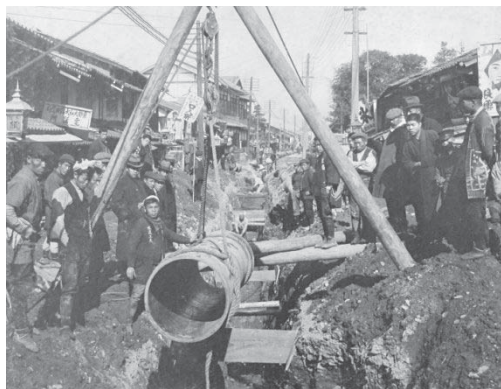
【建仁寺前配水管（24インチ管）の布設工事】
